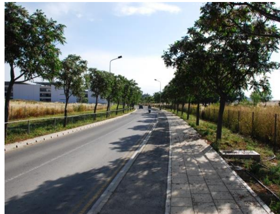
Εσωτερικό οδικό δίκτυο
