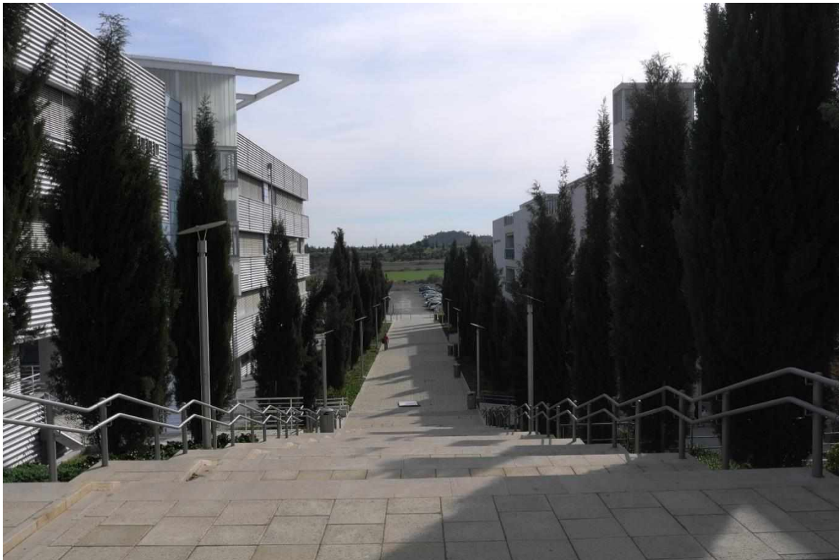
Φωτογραφία 6.1: Εσωτερικό δίκτυο πεζοδρόμων
